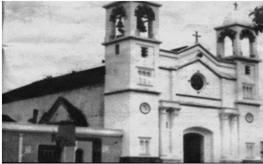
Iglesia Católica antes del terremoto
