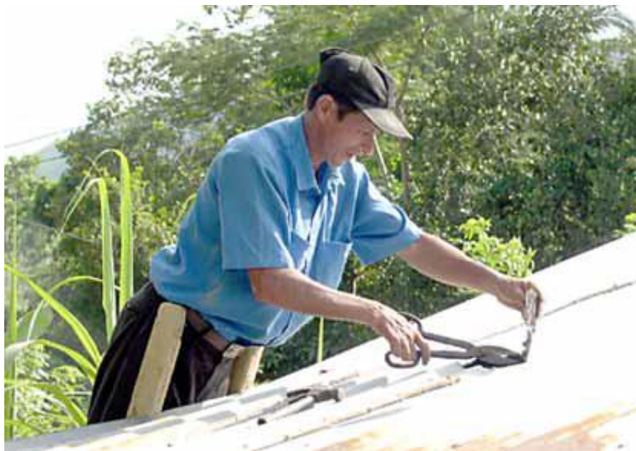
Abrir agujero en el techo para la chimenea.
