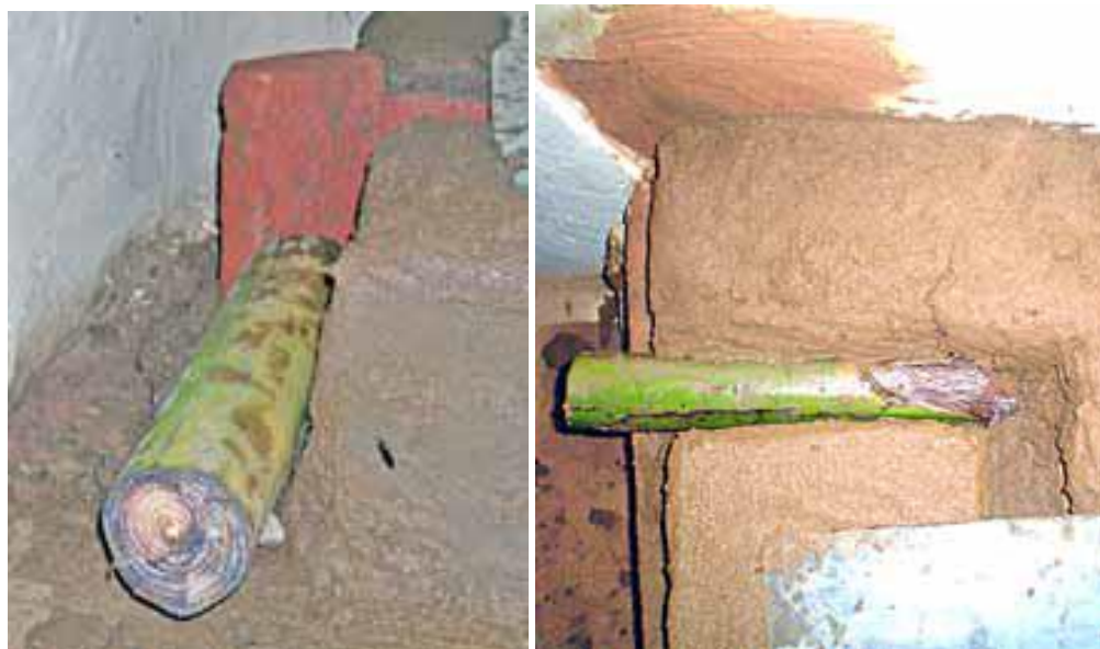
Construir agujero para la chimenea.
