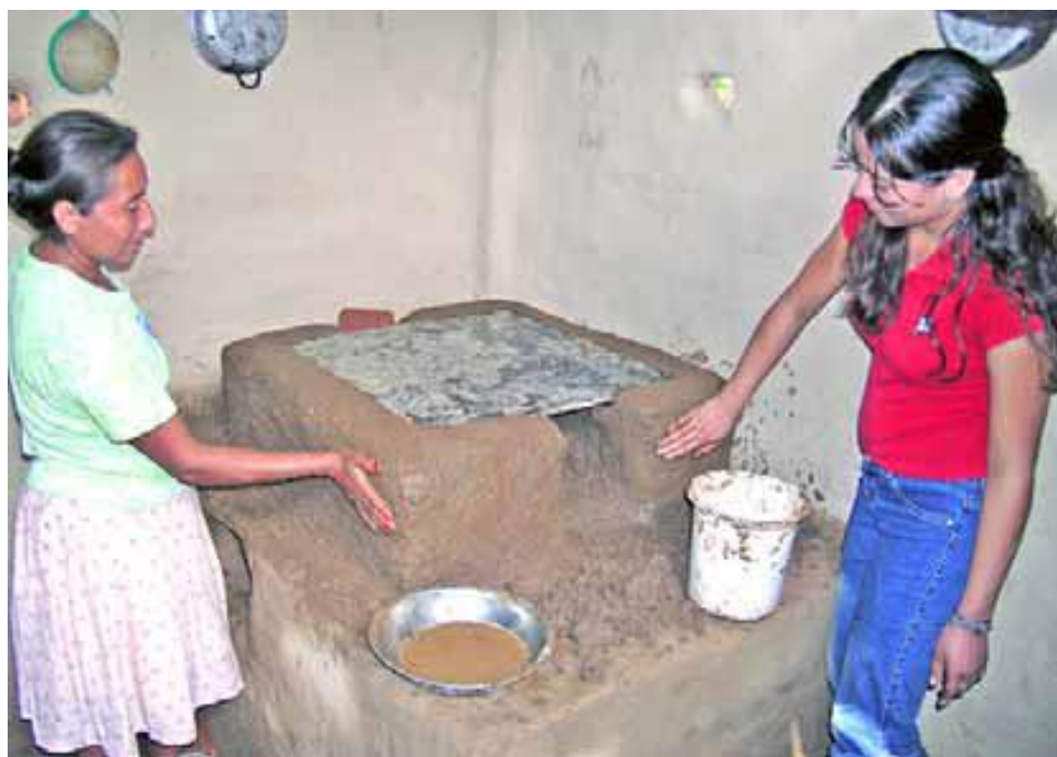
Revocar (cubrir) la estufa con la mezcla.
