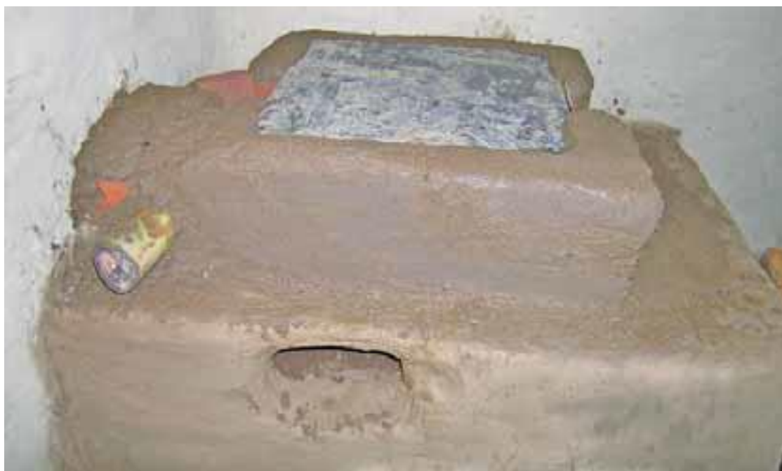
Agujero para limpiar la chimenea.
