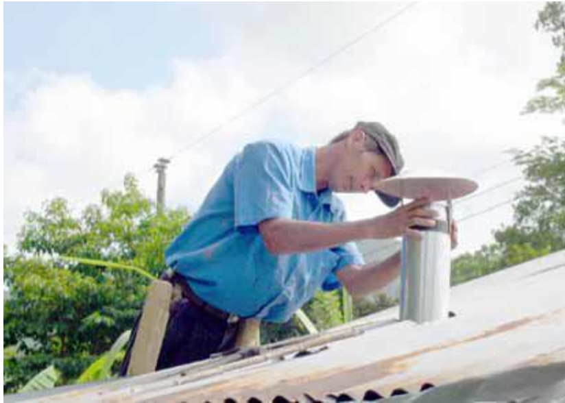
Instalar la chimenea.
