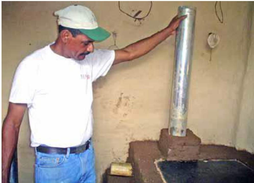
Colocar el tubo de la chimenea en la base.
