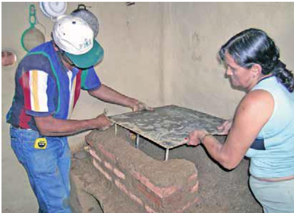
Colocar la plancha.
