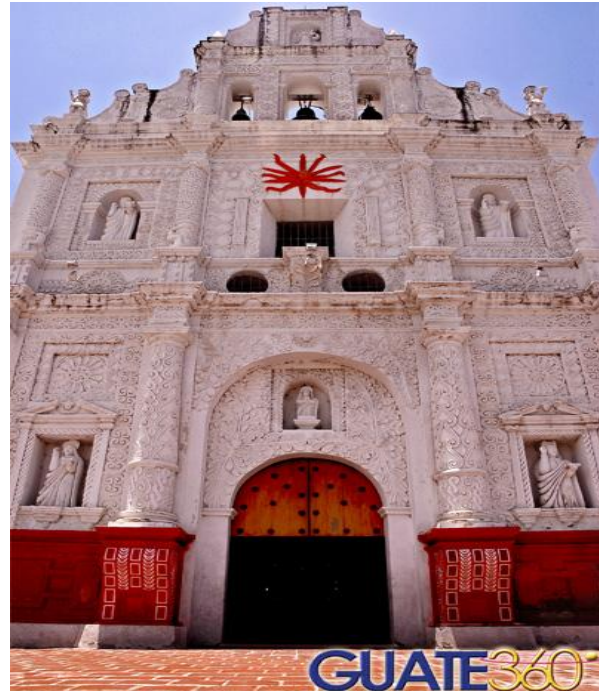
. Fachada de Iglesia Colonial Municipal
