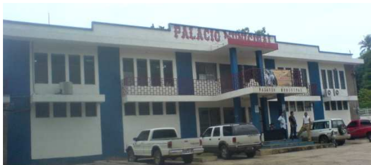
Foto: Actual Edificio Municipal, realizado de acuerdo a punto 8, del acta No 51-97 de fecha 31/10/97
