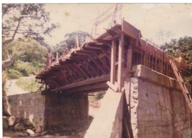
Foto: Construcción de Puente Sobre Río Chapetón en Caserío Las Marías 1989
