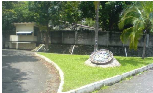
Foto: Entrada Principal Hidroeléctrica Aguacapa, Aldea La Unión
