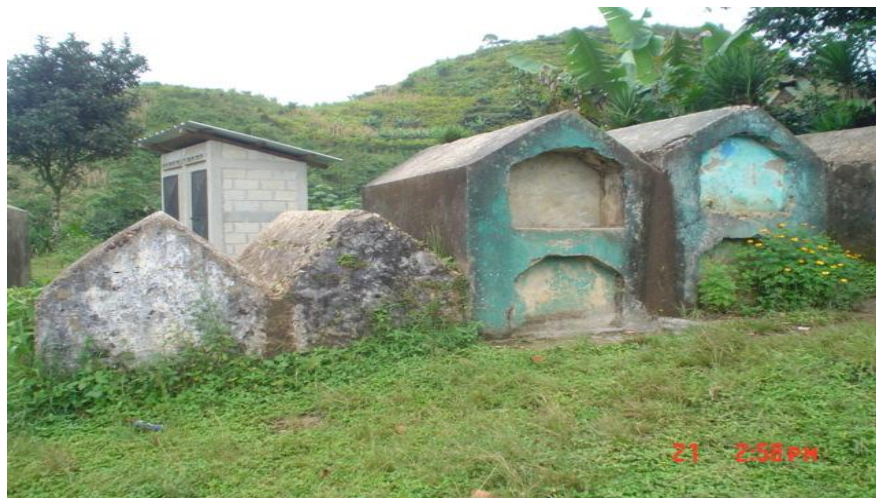
así lucía el cementerio comunal antes del proceso de pintura.
