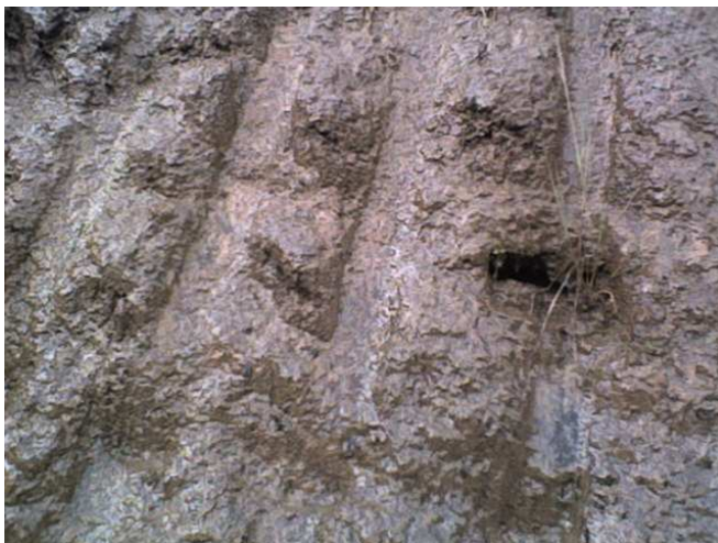
Erosión hídrica en Tululché IV. Foto: José Luis Guarcas.
